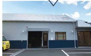
▲青山事務所施工写真
