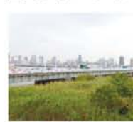
▲西淀川区と福島区を結ぶ淀川大橋。
