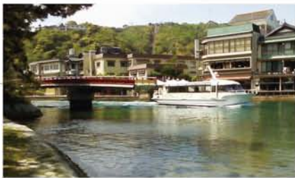
船が通るたびに90度旋回する廻旋橋。天橋立と文殊堂のある陸地をつなぐ橋です。
