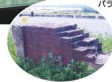
資料館裏にある、明治時代に大山崎の桂川の堤防に作られた煉瓦の礎管。
