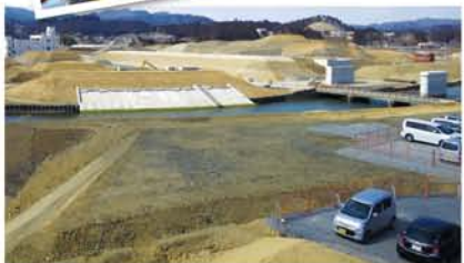
盛土工事が進む旧市街地。右端の赤茶色の鉄骨が多くの犠牲者を出した防災対策庁舎。
