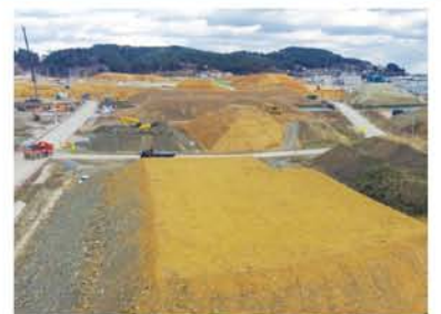
震災前は海に近く、利便性に優れた市街地だった場所。津波の被害を受け、現在は高上が進められています。
