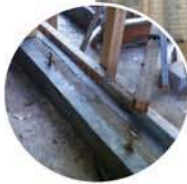
古い基礎を補修し、60年以上経過している柱も、増築部の2階はそのままで抜き換え補強しました。
