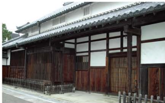
寺内町の創設に関わった庄屋のひとつで、重要文化財に指定されている旧杉山家住宅。中も見学可。当時の立派な造りを案内してもらえる。（菱川さん撮影）
