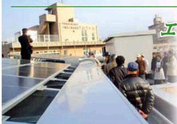
さわやか苑屋上に設置された太陽光パネル。玄関に発電量の表示板があるので、職員の人たちの省エネ意識にも繋がっているようです。
